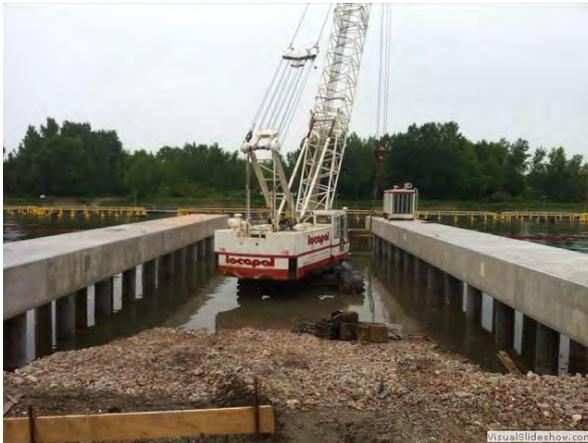
\* **NUOVA SISTEMAZIONE DELLA DARSENA CON LA REALIZZAZIONE DI NUOVO MOLO ALAGGIO/VARO** - MARINATRAVELIFT srl - Sarzana (SP) progetto di demolizione in acqua del molo esistente, costruzione del nuovo molo su pali e successiva sistemazione della darsena e banchina per l'attracco di imbarcazioni fino a 25/30 mt., cantiere 2011-2012
